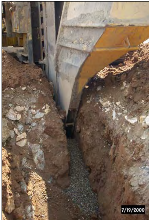
Abbildung 86. Errichtung der Drainwand am Standort Denkendorf mittels kontinuierlich arbeitender Schlitzfräse (oben: Befüllen der „Trench box“ mit Kies; unten: Detailaufnahme: mit Kies gefüllter und mit der „Trench box“ offen gehaltener Drainschlitz; I.M.E.S. GmbH, 2000).
