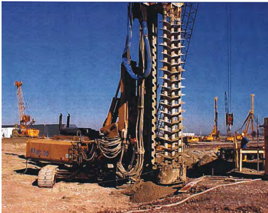
Abbildung 82. Errichtung einer Dichtwand mittels Mixed-in-Place-Verfahren am Flughafen München (Bild: Bauer & Mourik-Umwelttechnik GmbH, 2002)
