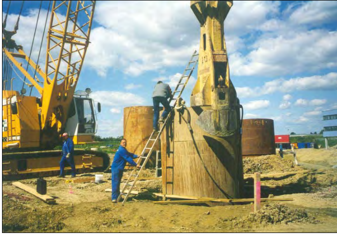
Abbildung 98. Standort Brunn am Gebirge, Österreich. Links: Einpressen des Mantelrohres mittels Greifer. Rechts: Einstellen des Schachtbauwerkes in den ausgehobenen Hohlraum des Mantelrohres (Bilder: Dr. Peter Niederbacher, Klosterneuburg)
