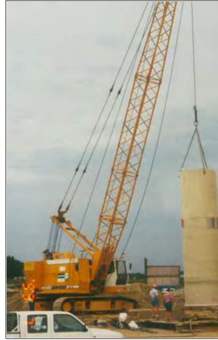
Abbildung 98. Standort Brunn am Gebirge, Österreich. Links: Einpressen des Mantelrohres mittels Greifer. Rechts: Einstellen des Schachtbauwerkes in den ausgehobenen Hohlraum des Mantelrohres (Bilder: Dr. Peter Niederbacher, Klosterneuburg)
