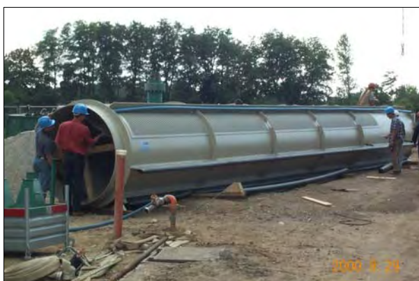
Abbildung 97. Einbau der vorgefertigten Reaktoren in eine Großbohrung am Standort Karlsruhe (Bilder: Stadtwerke Karlsruhe; I.M.E.S. GmbH, Amtzell)
