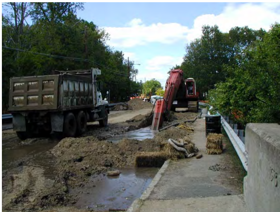
Abbildung 77. Errichtung einer Schlitzwand mit Tieföffelbagger im Zweiphasen-Verfahren unter Verwendung von Biopolymeren auf dem Standort Needham, Massachusetts, U.S.A., 2001 (Bild: ETI, 2002)
