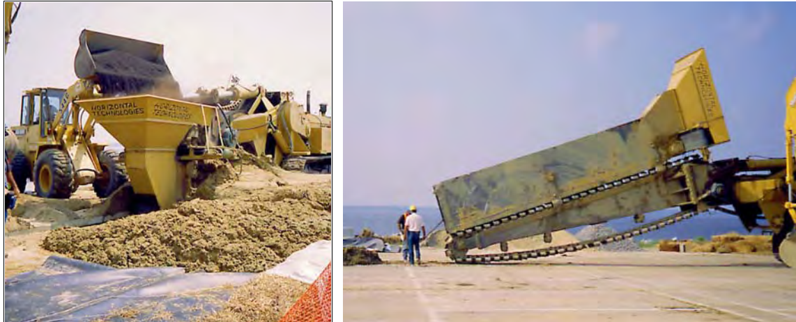
Abbildung 75. Kontinuierlich arbeitende Schlitzfräse mit Wiedereinfüllvorrichtung (links: Befüllung der „Trench box“; rechts: Fräsvorrichtung mit installierter „Trench box“; Standort Elizabeth City, North Carolina, U.S.A., 1996; Bilder: ETI, 2002)
