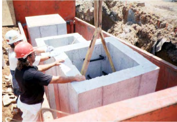
Abbildung 90. Errichtung eines gemauerten Schachtbauwerkes mit integriertem Reaktor am Standort Portadown, Nordirland (Bild: Kalin, 2002)
