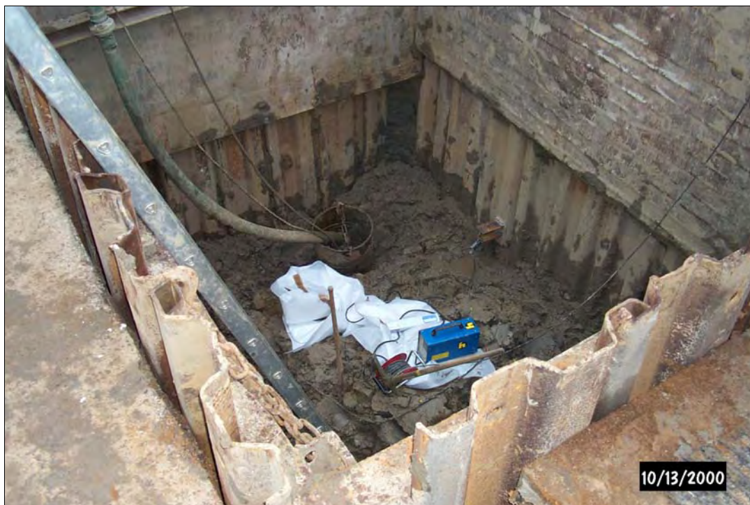
Abbildung 89. Standort Denkendorf, Deutschland: Spundwand-gestützte Baugrube, in die Betonschachtringe gestellt und ein Reaktor installiert wurde (Bild: I.M.E.S. GmbH, 2001)
