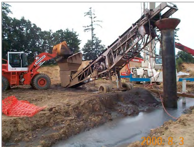
Abbildung 79. Befüllung eines biopolymergestützten Grabens mit Eisen-Sand-Gemisch auf dem Standort Somersworth, New Hampshire, U.S.A., 2000 mit Hilfe eines Schüttrohres (Bild: ETI, 2002)
