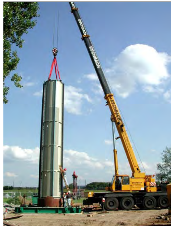
Abbildung 97. Einbau der vorgefertigten Reaktoren in eine Großbohrung am Standort Karlsruhe (Bilder: Stadtwerke Karlsruhe; I.M.E.S. GmbH, Amtzell)
