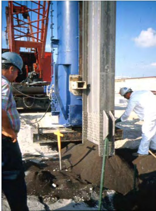
Abbildung 80. Verdrängungskörper zur Schmalwandherstellung (Bilder: ETI, 2002)
