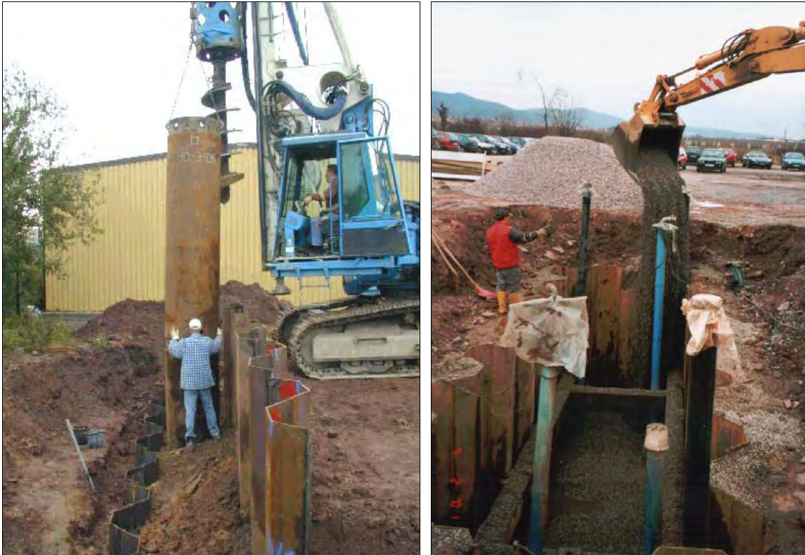
Abbildung 92. Errichtung eines Reaktorbauwerkes am Standort Edenkoben (links: Ausbohren eines Gates, rechts: Befüllung des Gates mit Eisen; Bilder: „Peschla & Rochmes“ GmbH, Kaiserslautern)
