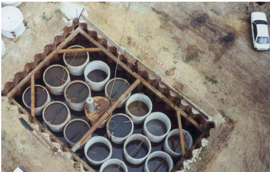
Abbildung 21. Standort Bernau vor der Inbetriebnahme 2001 (EC-PRB): Oberflächennahe Pilot-Reaktorzone (Gate), 5 m tief, mit 18 durchströmten Großsäulen, befüllt mit Eisen (noch in geöffnetem, teilweise nicht befülltem Zustand; Bilder: Koordinierung RUBIN, Universität Lüneburg). Detaildaten siehe Kapitel 4.5.1 und Übersichtsbericht im Anhang, vgl. auch Abbildung 91.
