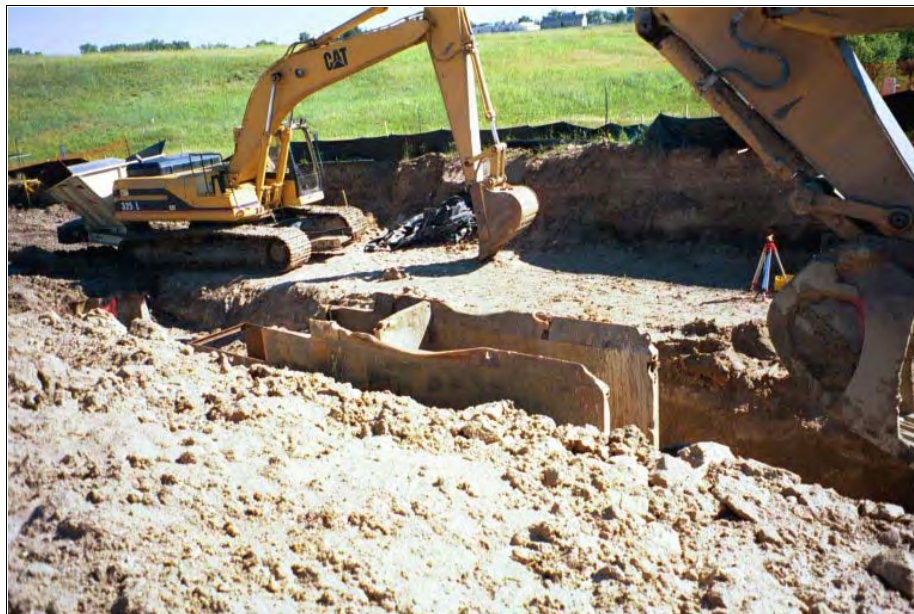
Abbildung 71. Auskoffern eines mit Verbaukästen gestützten Grabens (Standort Cheyenne, Wyoming, U.S.A., 1999; Bild: ETI, 2002)
