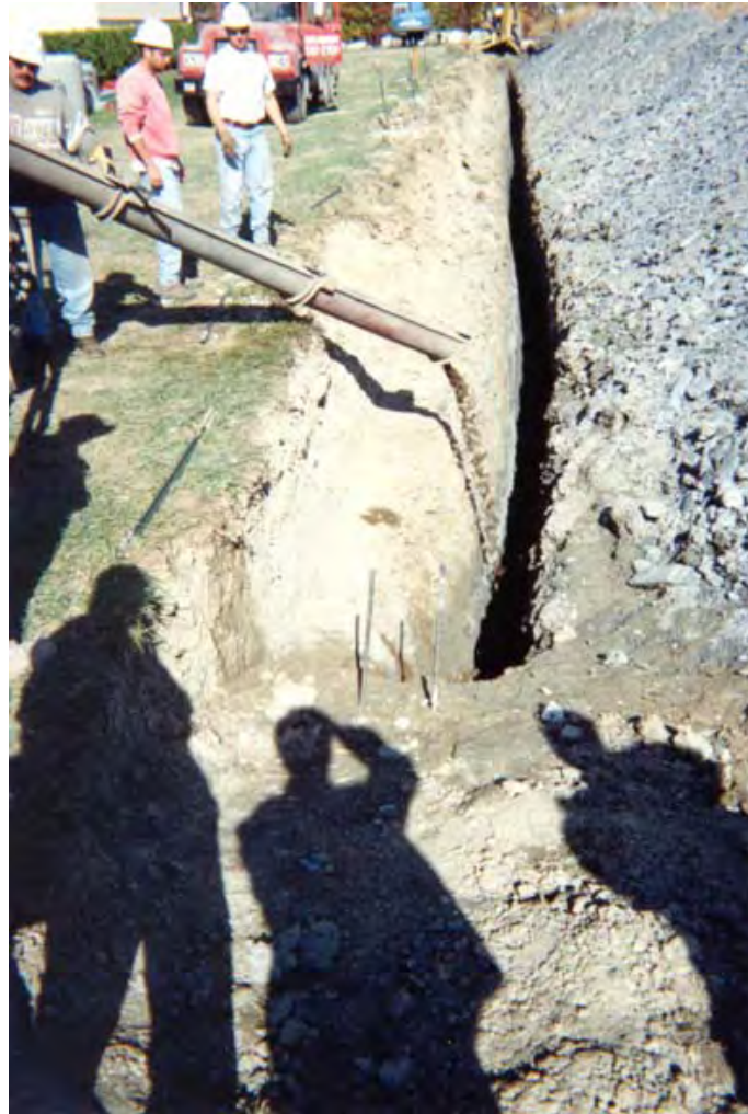
Abbildung 74. Befüllen eines ohne Verbaumaßnahme hergestellten Schlitzes (Standort Ohio, U.S.A., 1999; Bild: ETI, 2002)
