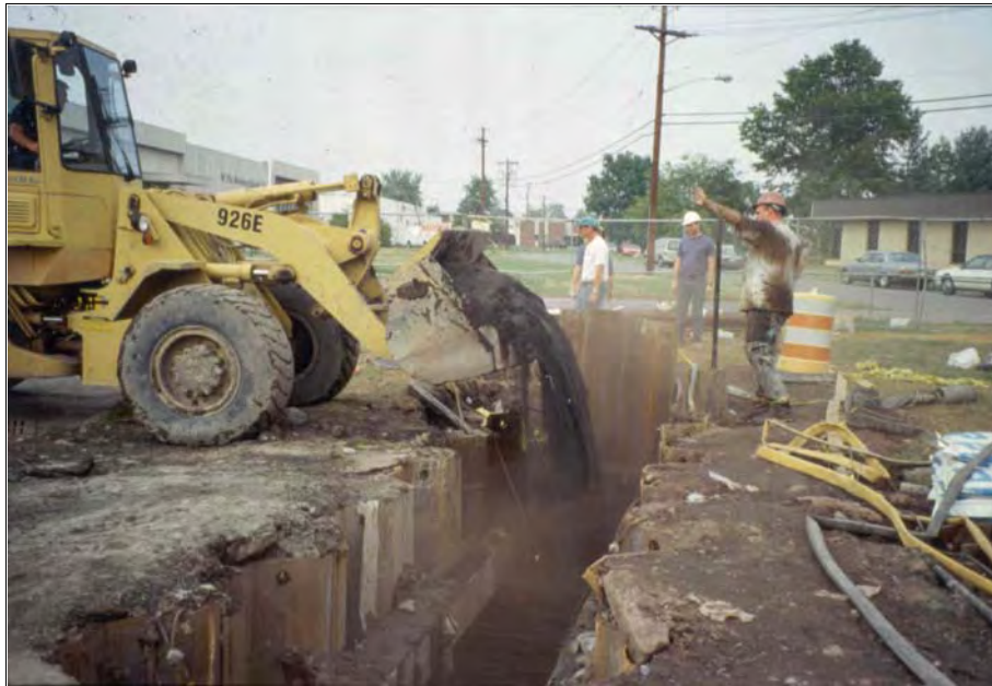
Abbildung 72. Befüllung eines mit Spundwänden verbauten Grabens mit Eisen-Sand-Gemisch nach Aushub (Standort New Jersey, U.S.A., 1998; Bild: ETI, 2002)
