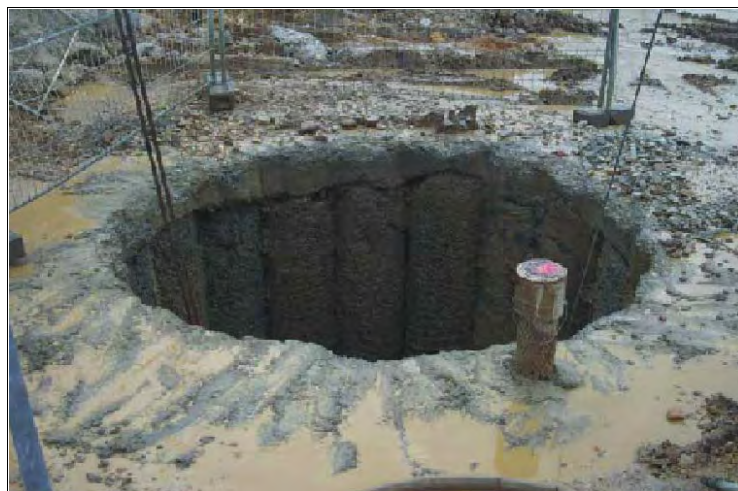
Abbildung 94. Standort Oberursel, Deutschland (2002): Gate-Errichtung innerhalb einer „Bohrschablone“; Gate bestehend aus wasserdurchlässigem Beton zur Aufnahme des Füllmaterials (Bilder: Bauer & Mourik, 2004; Arcadis, 2002; Arcadis 2004)
