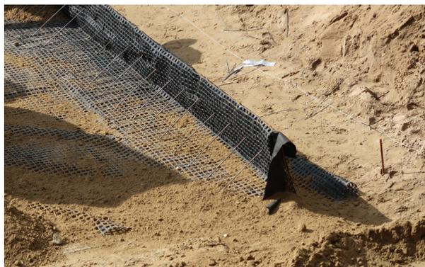
Geogitter-Bewehrung in einer Brückenkonstruktion.
