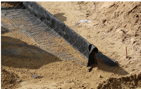
Geogitter-Bewehrung in einer Brückenkonstruktion.
