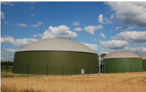
Biogasanlage mit Gärbehältern und Nachgärern
