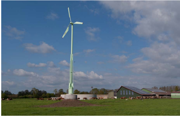
PSW Energiesysteme GmbH: Kleinwindenergieanlage im Betrieb
