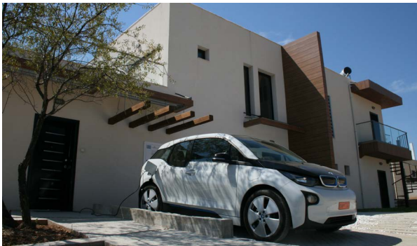
CERTH, Smart House – Ein Testgebäude des SIT4Energy-Projekts mit integrierter Ladeinfrastruktur für e-Autos in Thessaloniki, Griechenland
