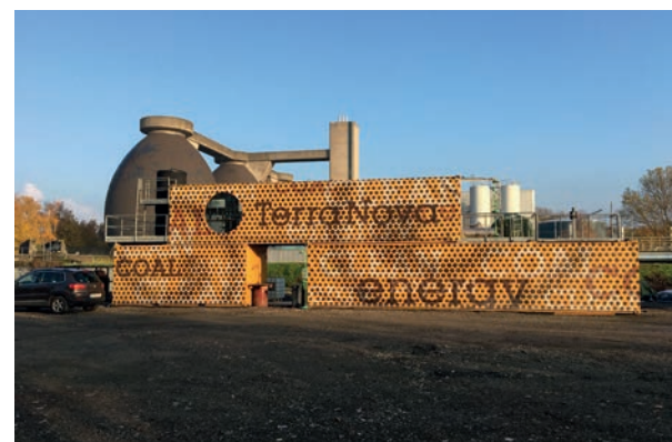
Anlage zur hydrothermalen Carbonisierung auf der Kläranlage Duisburg-Kaßlerfeld
