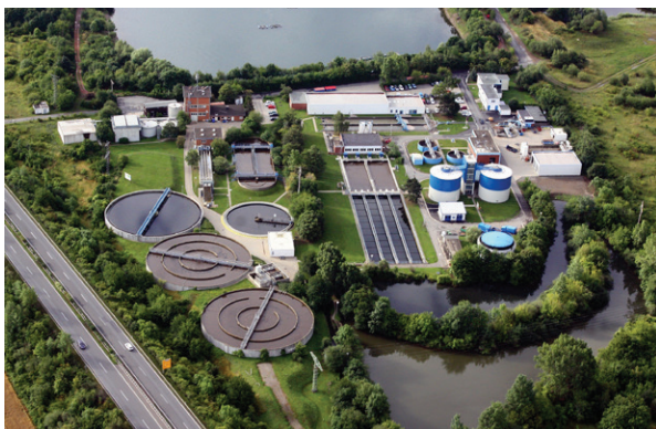
Auf dem Klärwerk in Goslar wird die Demonstrationsanlage aufgebaut
