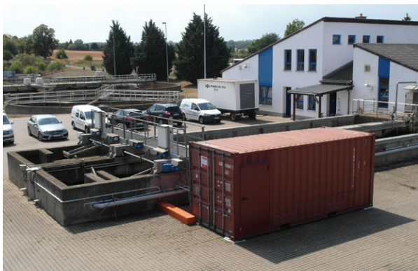
Anlagencontainer auf der Kläranlage Hecklingen
