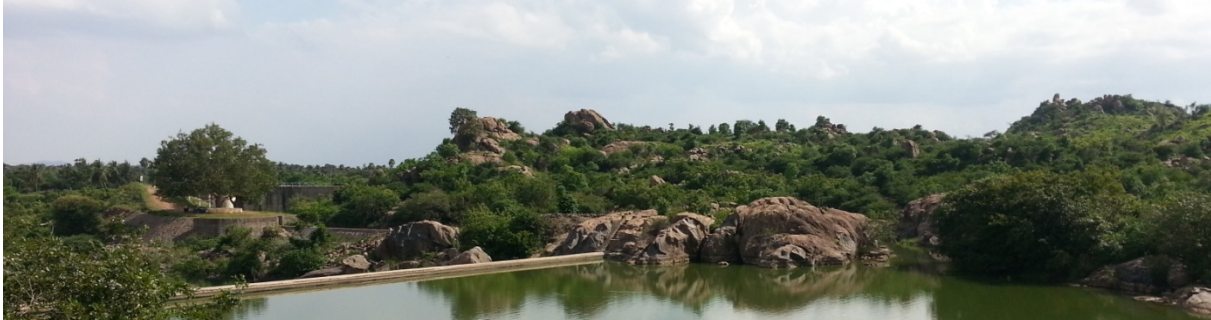
Wasserentnahmestelle für die Trinkwasserversorgung der Stadt Tiruvannamalai am Fluss Then-Pennaiyar (Quelle: IEEM).
