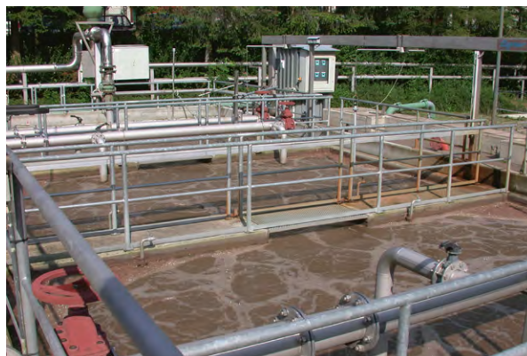
Im Belüftungsbecken der Kläranlage findet die biologische Phosphorrückgewinnung statt.
