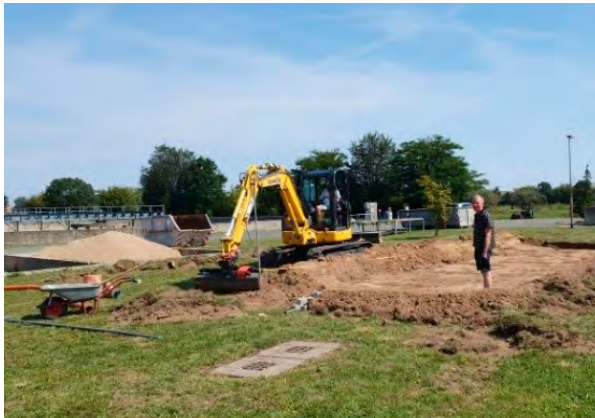
Zwei größere hydroponische Nesselbodenfilter werden angelegt, um Abwasser nachzubehandeln und Fasernesseln zu produzieren.
