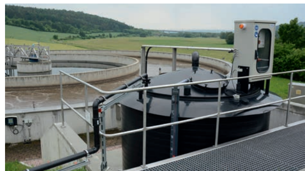
Der Phosphatsensor soll zur fortlaufenden Überwachung der Phosphatkonzentrationen in Zu- und Abläufen von Kläranlagen eingesetzt werden
