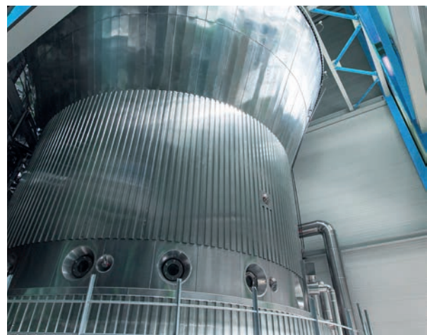
Das Verbundprojekt CYKATT setzt einen Wirbelschichtverdampfungstrockner für nachhaltige Kläranlagenkonzepte ein. Das Bild zeigt ein Beispiel aus der Zuckerindustrie.
