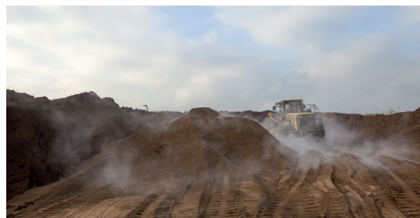
Deponierung von Klärschlammasche ohne Wertstoffrückgewinnung
