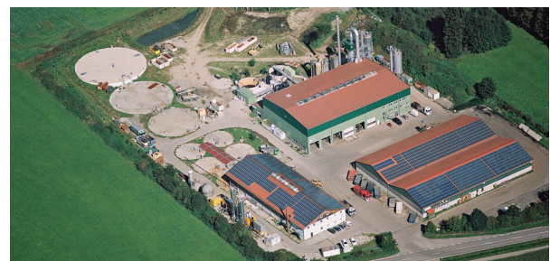
Die AshDec-Demonstrationsanlage entsteht am Standort der Klärschlammverbrennungsanlage Altenstadt (Emter GmbH).
