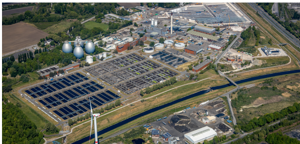
Die Kläranlage Bottrop ist der zukünftige Standort der Demonstrationsanlage.
