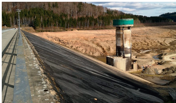
Die sächsische Talsperre Lichtenberg wurde zur Inspektion und Instandsetzung abgelassen.
