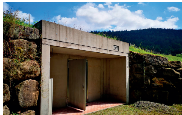
Schutzbauwerk für eine Quelfassung im Projektgebiet
