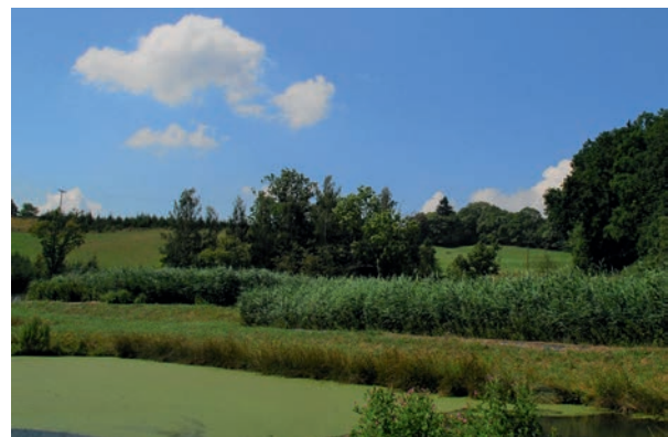
Pflanzenkläranlagen sind energieeffiziente Verfahren, die zur Industrieabwasserbehandlung weiterentwickelt werden
