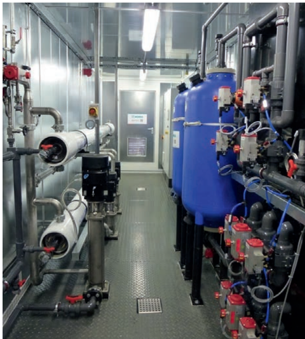
Wertstoffrückgewinnung: In einer Nanofiltrationsanlage werden organische und anorganische Bestandteile von Konzentraten getrennt.
