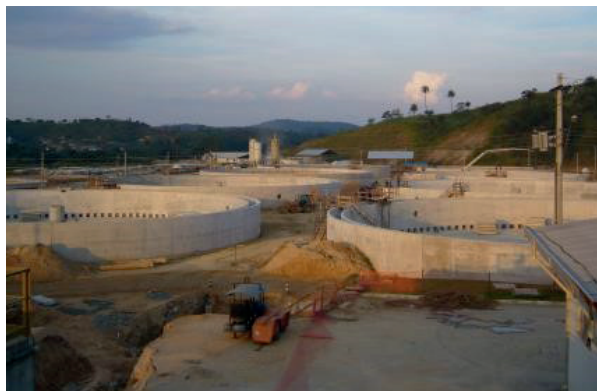
Bau von Tropfkörpern auf einer Kläranlage in Südamerika
