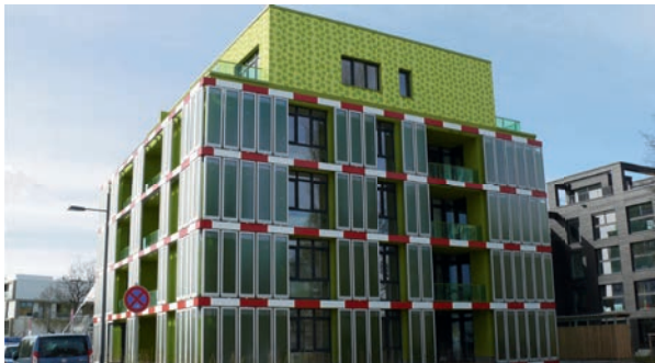
Das Algenhaus BIQ in Hamburg hat eine 200 Quadratmeter große Bioreaktorfassade zur Produktion von Biomasse und Wärme.
