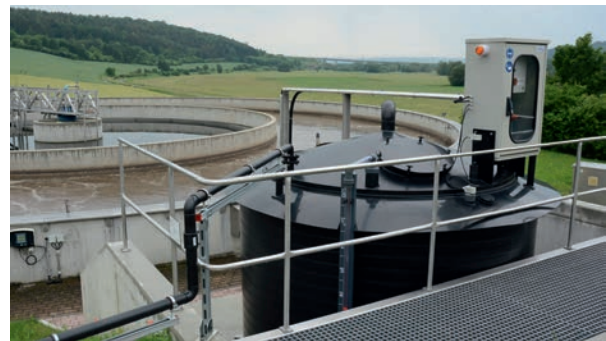
Der Phosphatsensor soll zur fortlaufenden Überwachung der Phosphatkonzentrationen in Zu- und Abläufen von Kläranlagen eingesetzt werden
