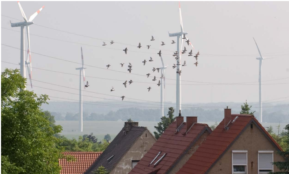
Windkraftanlagen nahe einer Wohnsiedlung
