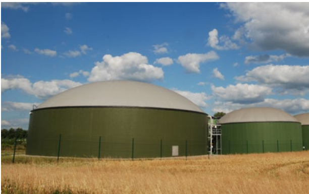
Biogasanlage mit Gärbehältern und Nachgärern
