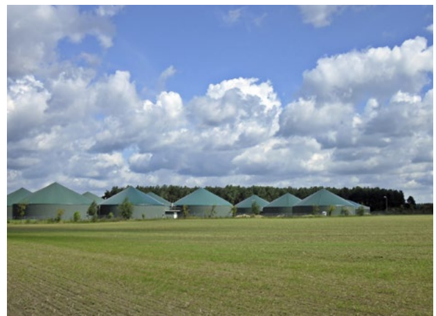
Der Verbund MOST entwickelt eine leicht anwendbare Prozessmess- und Prozesssteuerungstechnik für Biogasanlagen.
