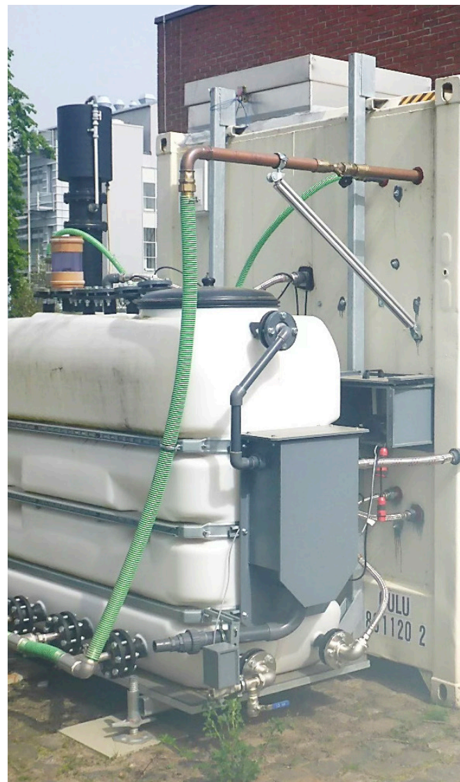
Pilotanlage des Membranbioreaktors mit Aktivkohledosierung und UV-Desinfektion, untergebracht in einem Container (Quelle: Aaron Bauer)
