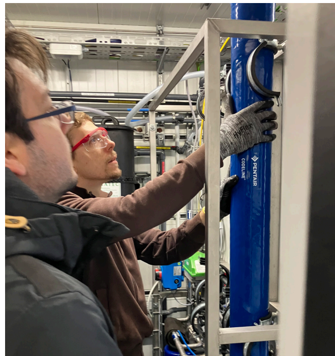
Membranwechsel an der Umkehrosmoseanlage (Quelle: SMS)
