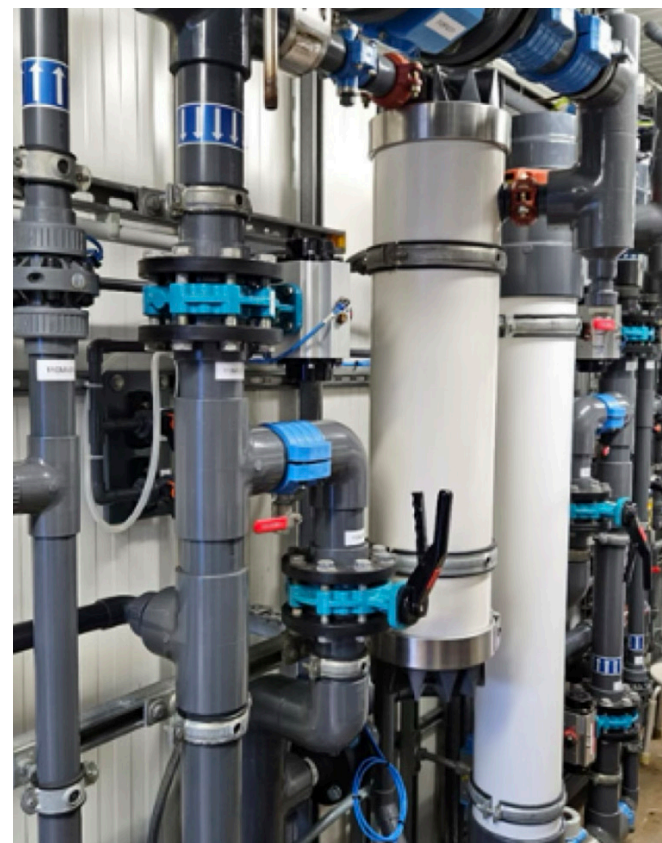
Pilotanlage mit zwei Ultrafiltrationsmodulen mit polymeren Hohlfasermembranen (Quelle: OOWV)
