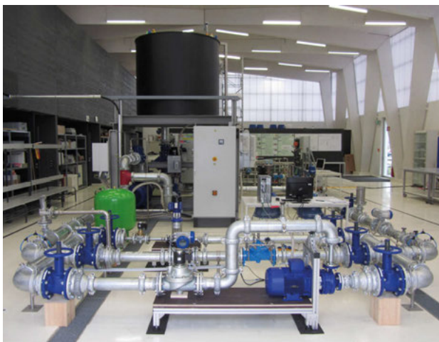
Abb. 2: Teststrecke mit den verschiedenen Versuchseinrichtungen
