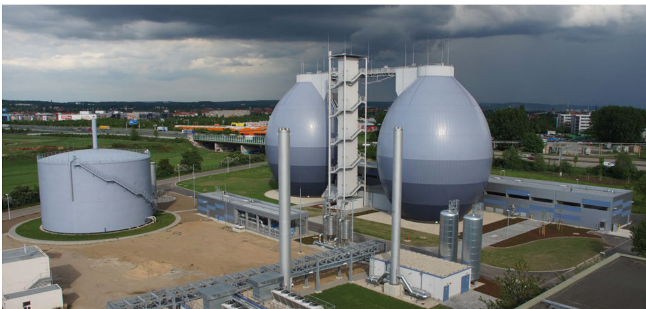
Abb. 1: Schlammbehandlungsanlage Dresden-Kaditz der Stadtentwässerung Dresden GmbH
