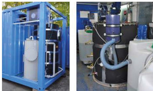
Abb. 3: Fotos der Versuchsanlage zur Faulung
